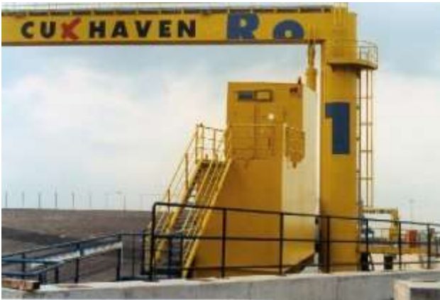
Abb.: Das Maschinenhaus ist zweigeteilt und bietet genug Platz für die gesamte Hydraulikanlage, das Steuerpult sowie elektrische und elektronische Anlagenteile.
