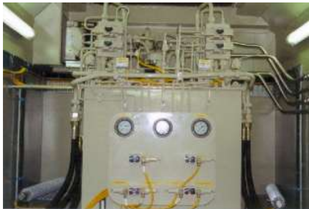
Abb.: Das Maschinenhaus ist zweigeteilt und bietet genug Platz für die gesamte Hydraulikanlage, das Steuerpult sowie elektrische und elektronische Anlagenteile.
