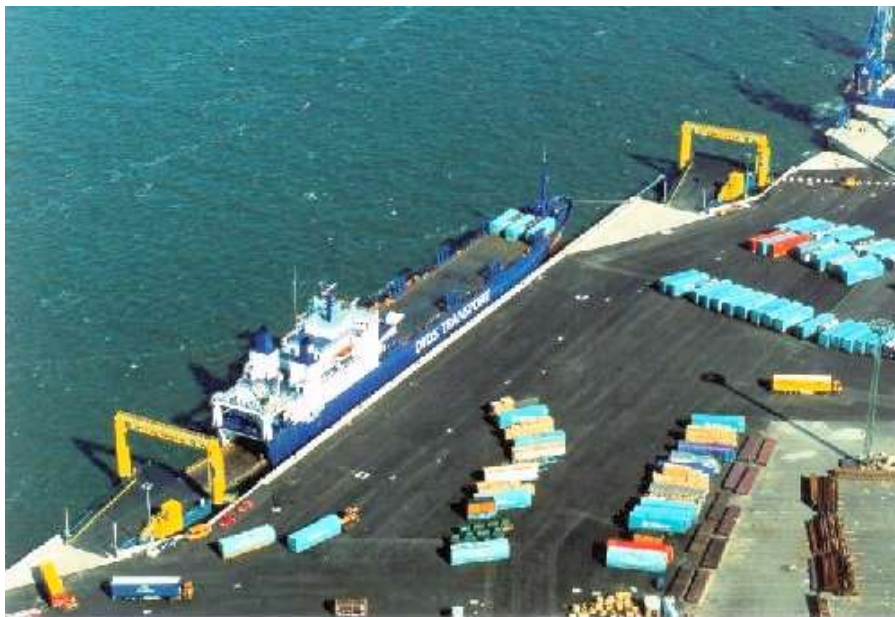
Abb.: Die zwei baugleichen RoRo-Anlagen machen den „EuropaKai Cuxhaven“ zu einem vielseitigen Umschlagplatz.
