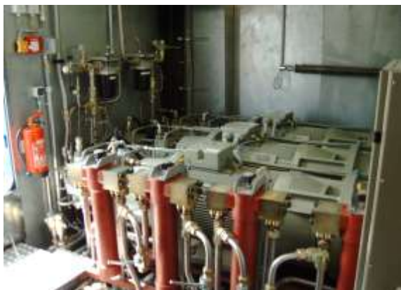
Abb.: Im Maschinenhaus befinden sich unter anderem die E- Anlage und die Hydraulikaggregate mit den Steuerventilen.
