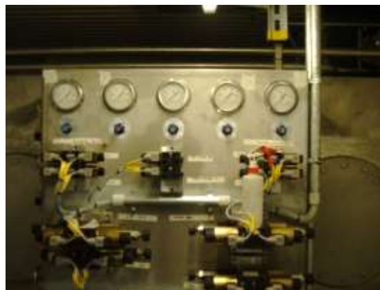
Abb.: Im Maschinenhaus befinden sich unter anderem die E- Anlage und die Hydraulikaggregate mit den Steuerventilen.
