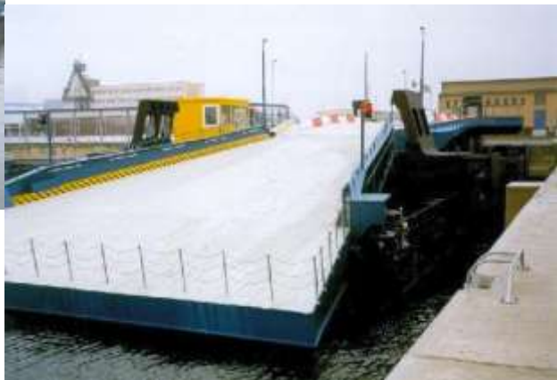
Abb.: Der Anleger ist für Fährschiffe mit einer maximalen Schiffsklappenbreite von 18 m und einer Schiffsklappenlänge von 15 m ausgelegt.
