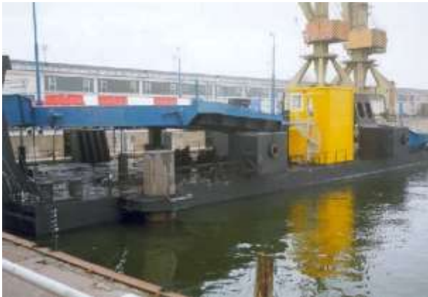
Abb.: Der Anleger ist für Fährschiffe mit einer maximalen Schiffsklappenbreite von 18 m und einer Schiffsklappenlänge von 15 m ausgelegt.
