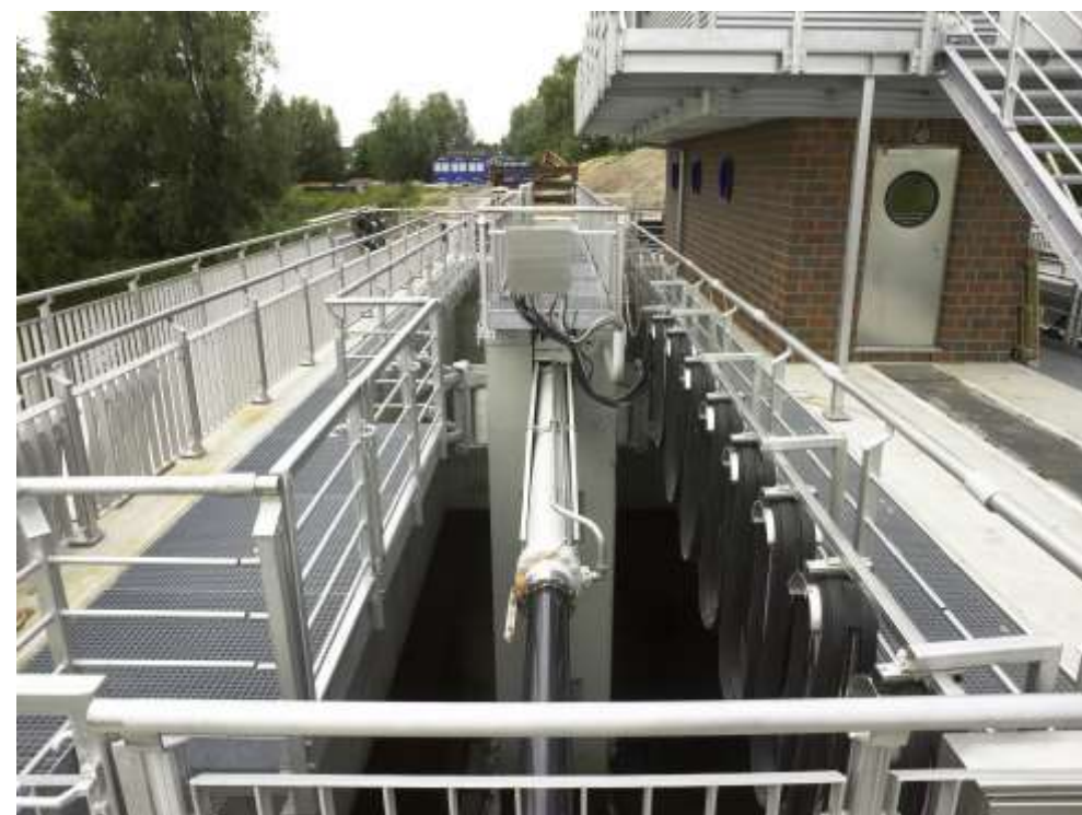
Abb.: Schubzylinder bei halb geschlossenem Tor
