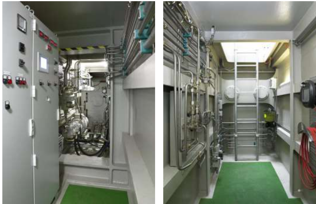
Abb.: Oberer Bereich eines Schiebetors des Außenaupts, der als Maschinenraum fungiert
