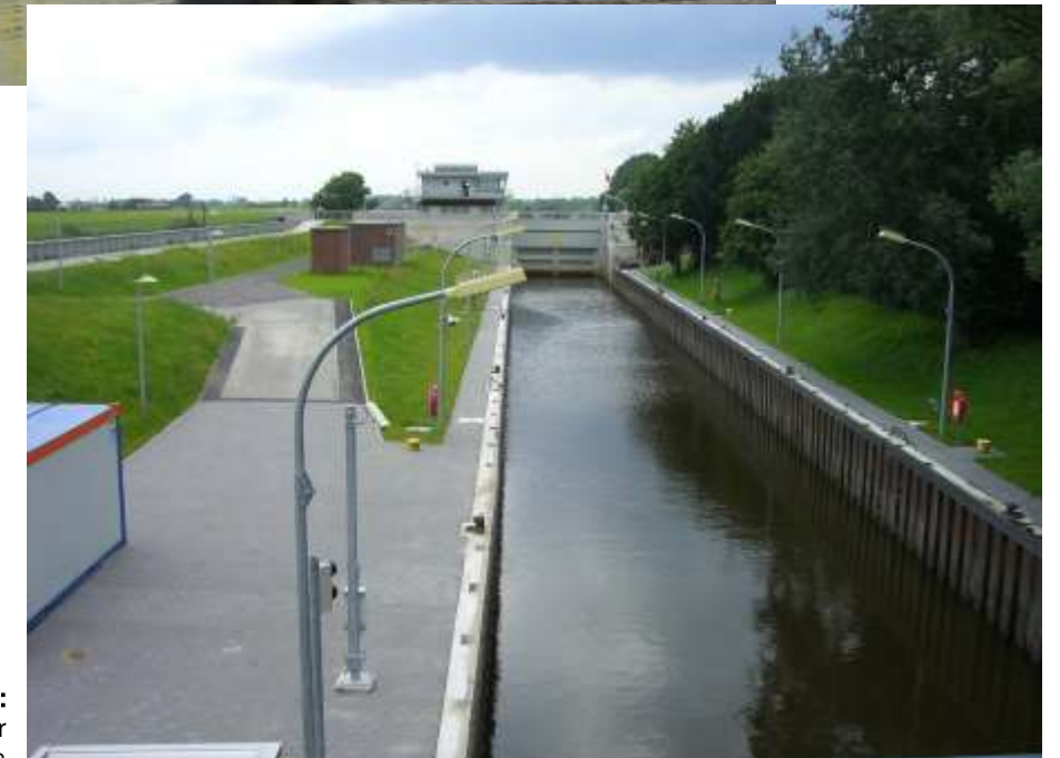
Abb.: Schleusenkammer und Außenanlagen
