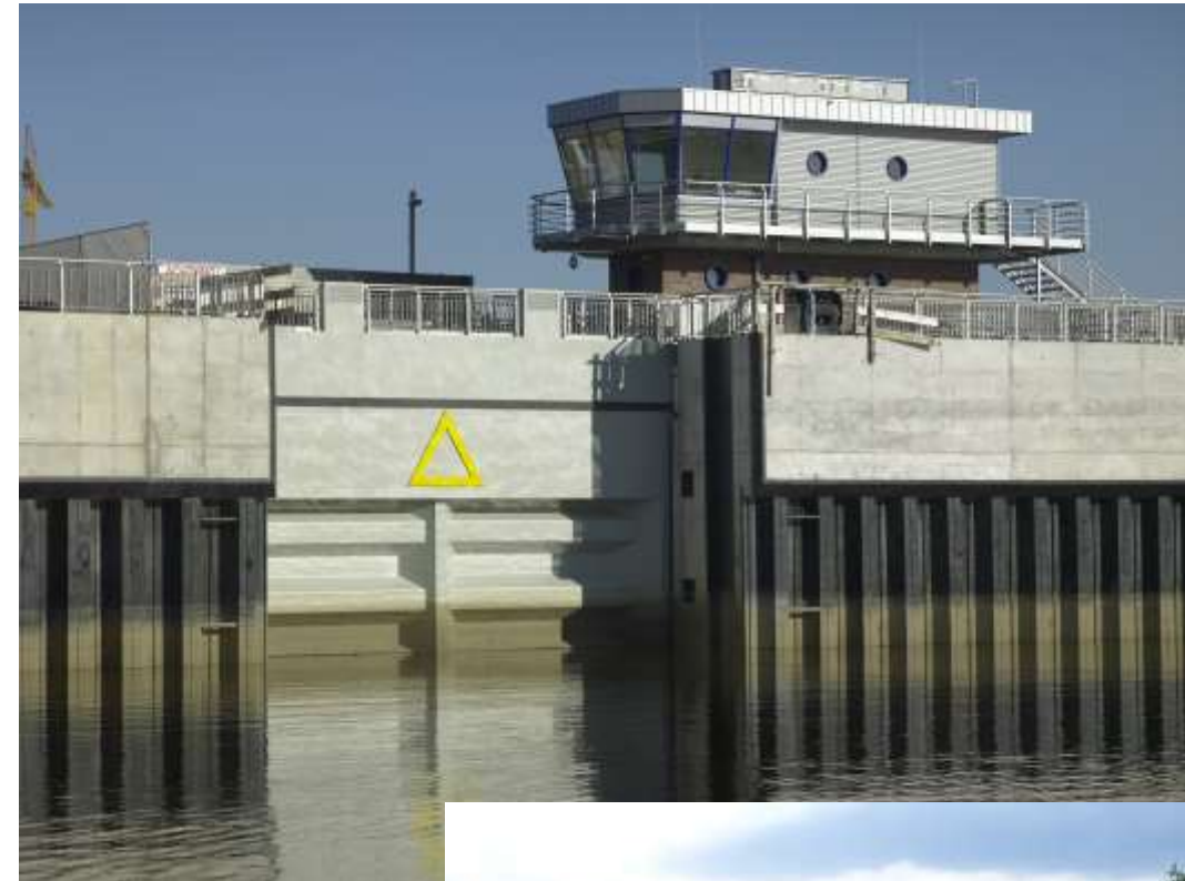
Abb.: Neues Schiebetor, geschlossen; Blickrichtung West
