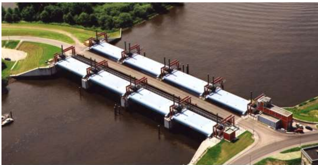
Abb.: Im Rahmen des Hamburger Hochwasserschutzprogramms wurde das Sturmflut-Sperrwerk Billwerder Bucht umgebaut und um eine neue Sperrwerkslinie erweitert.
