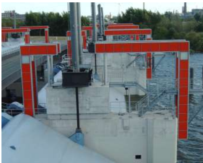
Abb.: Die Schifffahrtstore sind besonders schnell zu öffnen und zu schließen.
