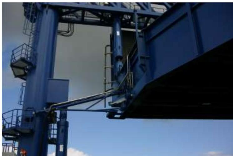
Abb.: Oberdeckbrücke mit Hubzylinder und Hubpfahl
